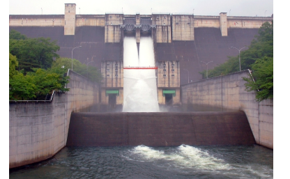
▲点検時に非常用洪水吐きゲートから試験放流
