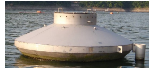
深層曝気設備
