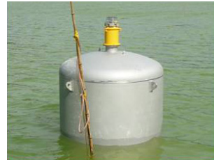
浅層曝気設備
